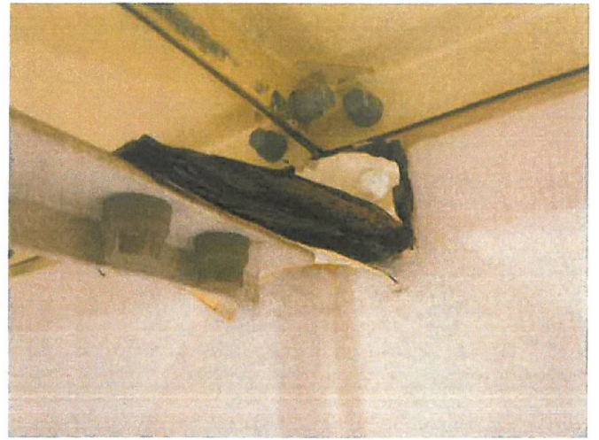
No. 2 ステー状況
