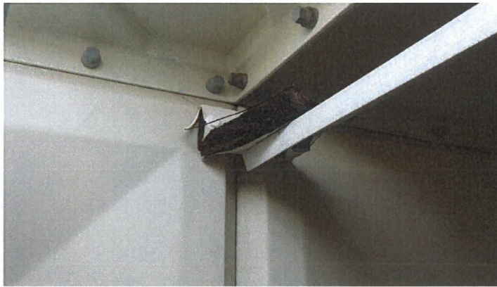
No. 3 ステー状況
