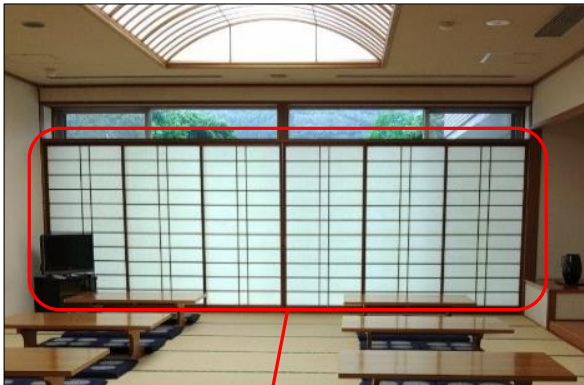
(6) 既存障子を撤去し、カーテン及びカーテンレールを設置する。
