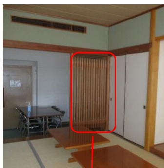
(6) 既存障子を撤去し、カーテン及びカーテンレールを設置する。
